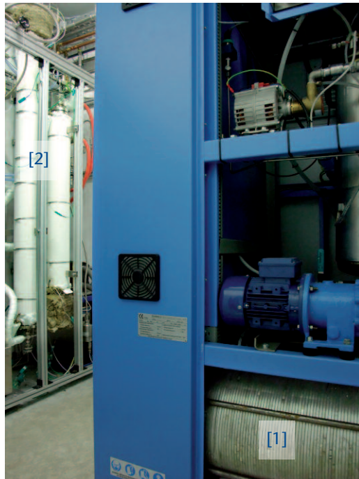
Abbildung 4 Containerintegrierte Wind-to-SNG-Anlage mit Elektrolysestack [1] und Methanisierungs- apparatur [2]
