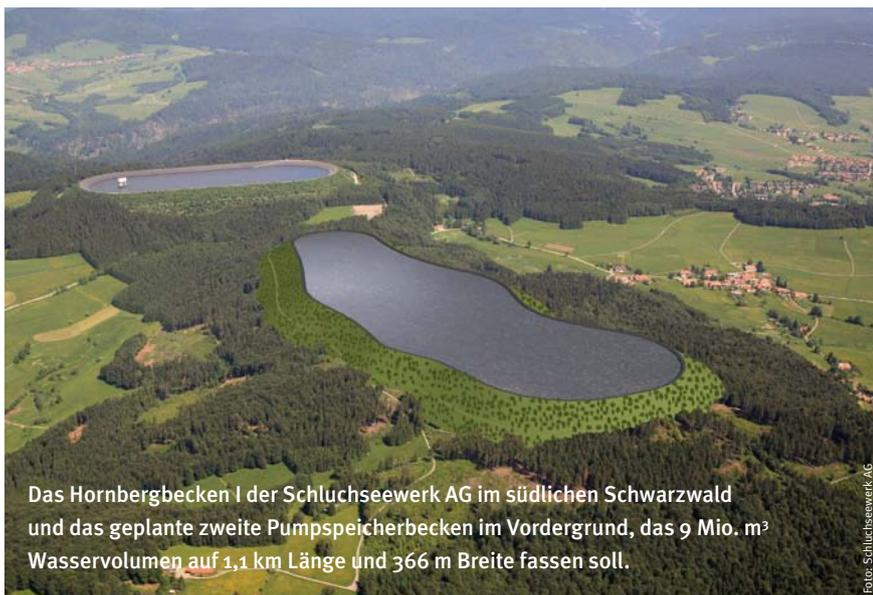
Das Hornbergbecken I der Schluchseewerk AG im südlichen Schwarzwald und das geplante zweite Pumpspeicherbecken im Vordergrund, das 9 Mio. m<sup>3</sup> Wasservolumen auf 1,1 km Länge und 366 m Breite fassen soll.
