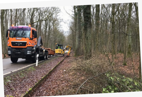
Bauhofmitarbeiter und Maschinen, Foto: Schauder
